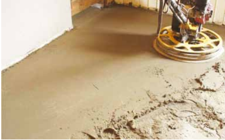
Posadzka betonowa – ślepe testy w aplikacji posadzki
