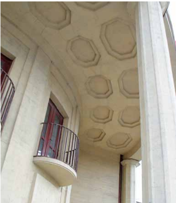
Fot. 10. Widok fragmentu portyku Hali Stulecia we Wrocławiu po wykonaniu prac naprawczych, fot. L. Konarzewski
