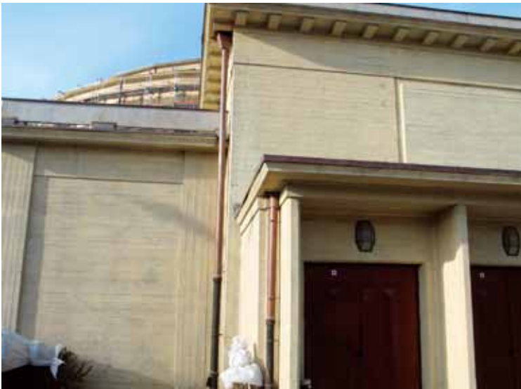
Fot. 9. Widok fragmentu ściany Hali Stulecia we Wrocławiu pod koniec prac renowacyjnych, fot. L. Konarzewski
