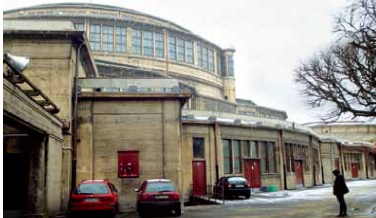
Fot. 4. Widok fragmentu ściany Hali Stulecia we Wrocławiu przed renowacją elewacji, fot. M. Pawłowski
