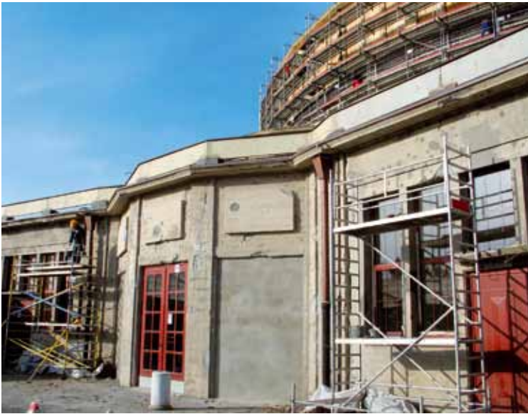
Fot. 5. Widok fragmentu ściany Hali Stulecia we Wrocławiu w czasie prac naprawczych, fot. L. Kona-rzewski
