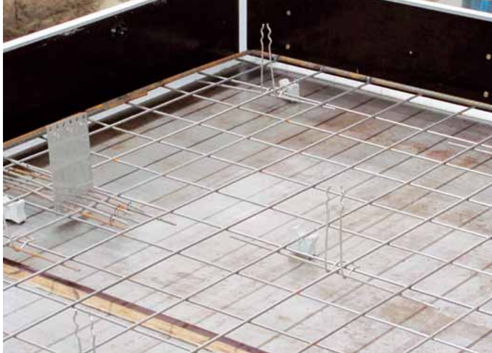
Rys. 3 Rozmieszczenie kotew w elemencie, źródło K. Chęcińska
