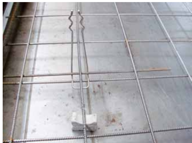
Rys. 2. Szpilka kotwiąca, źródło K. Chęcińska
