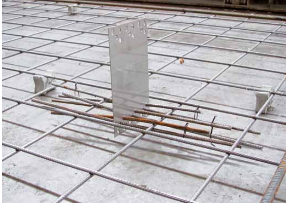
Rys. 1. Kotwa płaska, źródło K. Chęcińska
