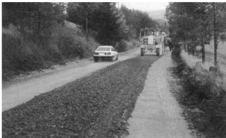
Ryc. 1. Recykling i stabilizacja destruktu mas drogowych [4]
