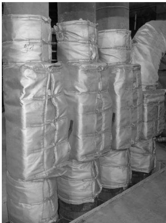
Ryc. 5. Izolacja przewodów pyłowych
