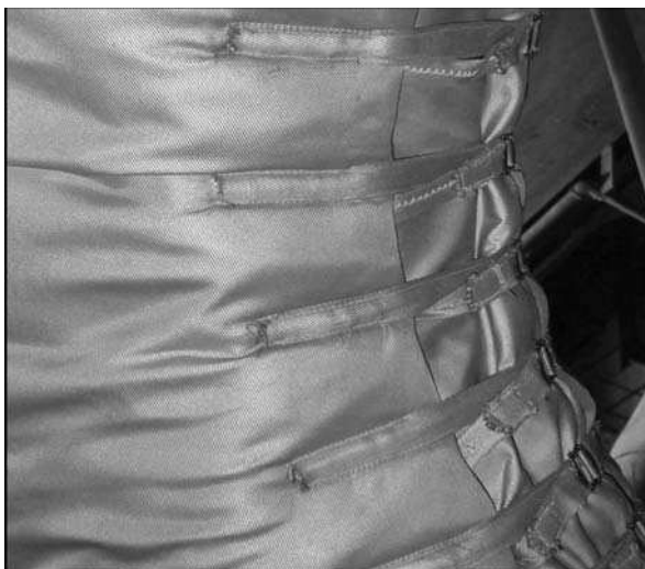
Ryc. 7. Izolacja kolan pyłowych
