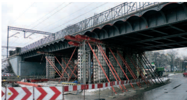
Fot. 9. Widok podpartego wiaduktu nad ul. Zaporoską we Wrocławiu
