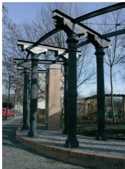
Fot. 5. Pomnik kolumny Hartunga zbudowany z fragmentów wiaduktu znad Stadthausstraße w Berlinie
