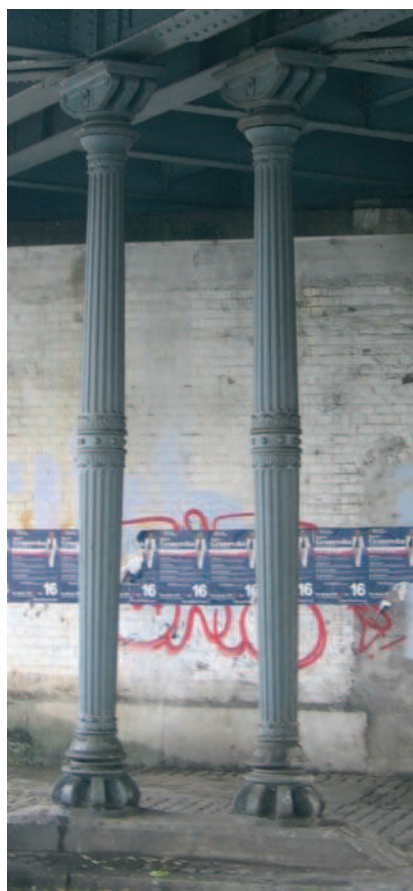
Fot. 7. Widok słupów Hartunga w wiadukcie nad ul. Stysia we Wrocławiu
