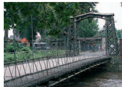
Fot. 3. Istniejący żeliwny most wiszący w Ozimku (1827 r.)
