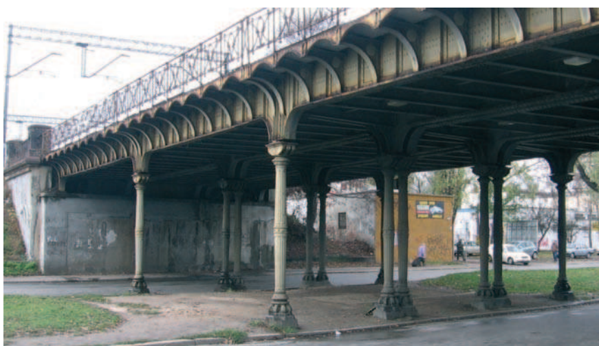
Fot. 6. Widok wiaduktu kolejowego ze słupami Hartunga w ciągu ul. Zaprowskiej we Wrocławiu
