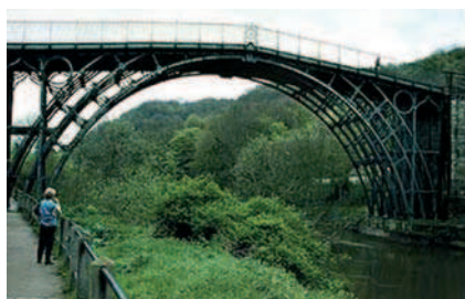
Fot. 1. Żeliwny most nad rzeką Severn
