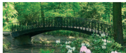
Fot. 13. Żeliwny mostek łukowy w Parku Szczytnickim we Wrocławiu
