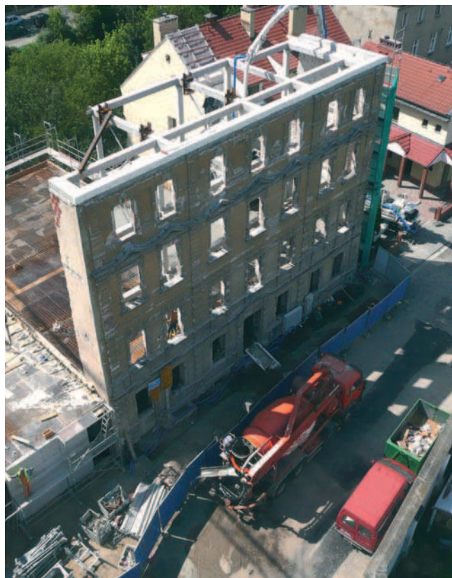
Rys. 6. Widok na konstrukcję ściany
