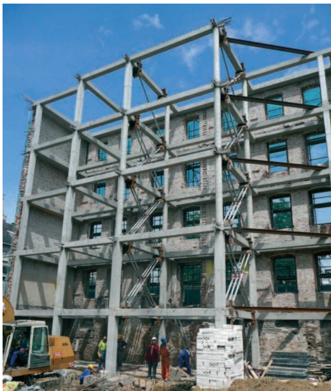
Rys. 3. Konstrukcja podporowa ściany
