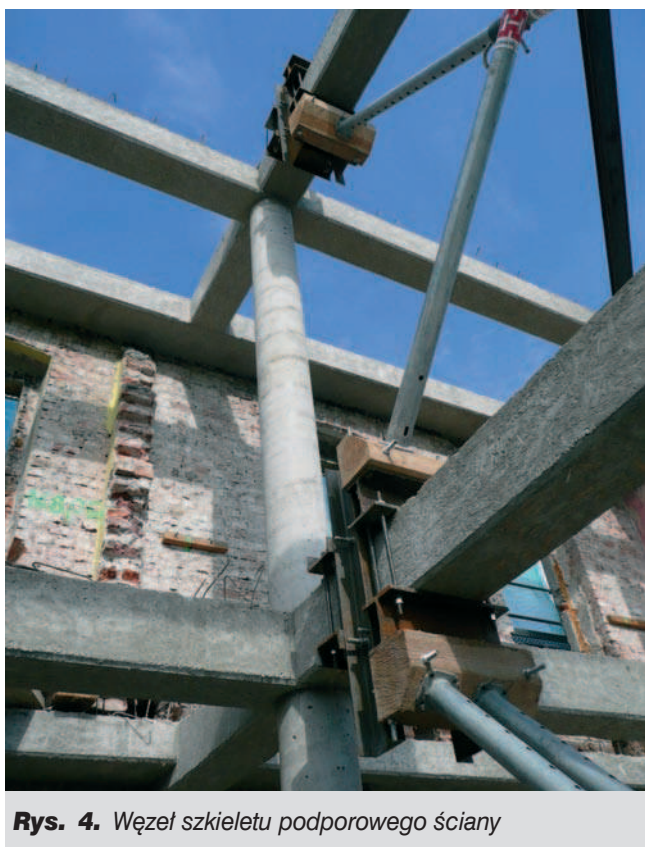
Rys. 3. Konstrukcja podporowa ściany
