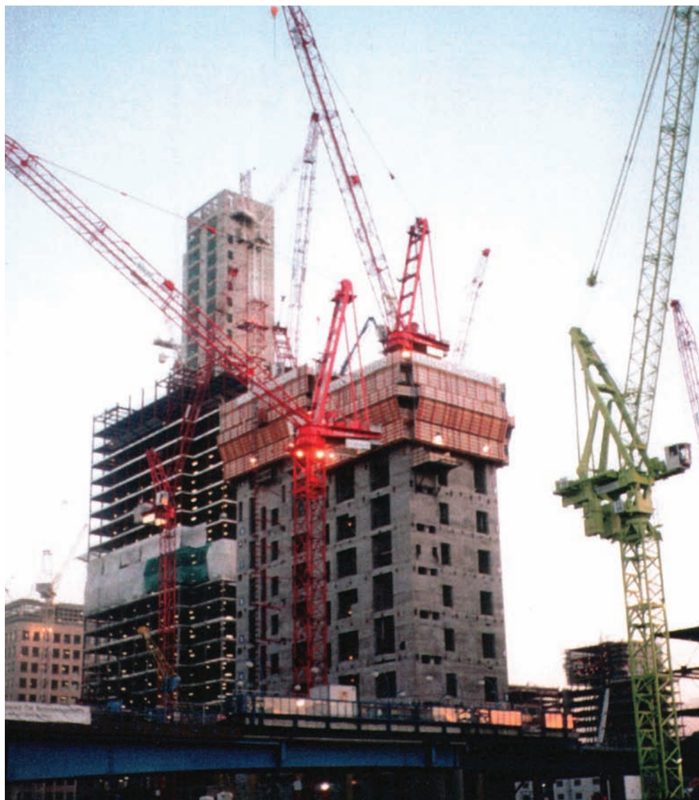
Londyńskie centrum międzynarodowego biznesu Canary Wharf – stropy wykonane w technologii pollytagbetonu
