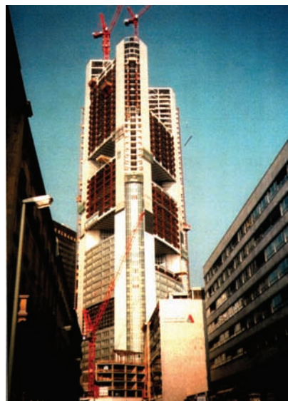
Biurowiec Commerzbanku we Frankfurcie nad Menem (63 piętra, 258,7 m wysokości). Stropy wykonane w technologii mieszanej stalowo-żelbetowej z użyciem betonu lekkiego klasy LB50 na kruszywie Lytag
