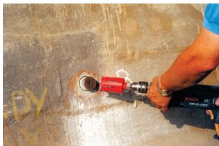
Fot. 5. Widok sposobu wykonania nacięcia wokół przyklejonego krążka metalowego
