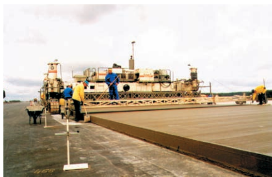
Fot. 1. Układarka nawierzchni Wirtgen podczas pracy na lotnisku
