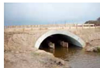
Stan obiektu nr 1, po przebudowie (2010), źródło J. Uczciwek
