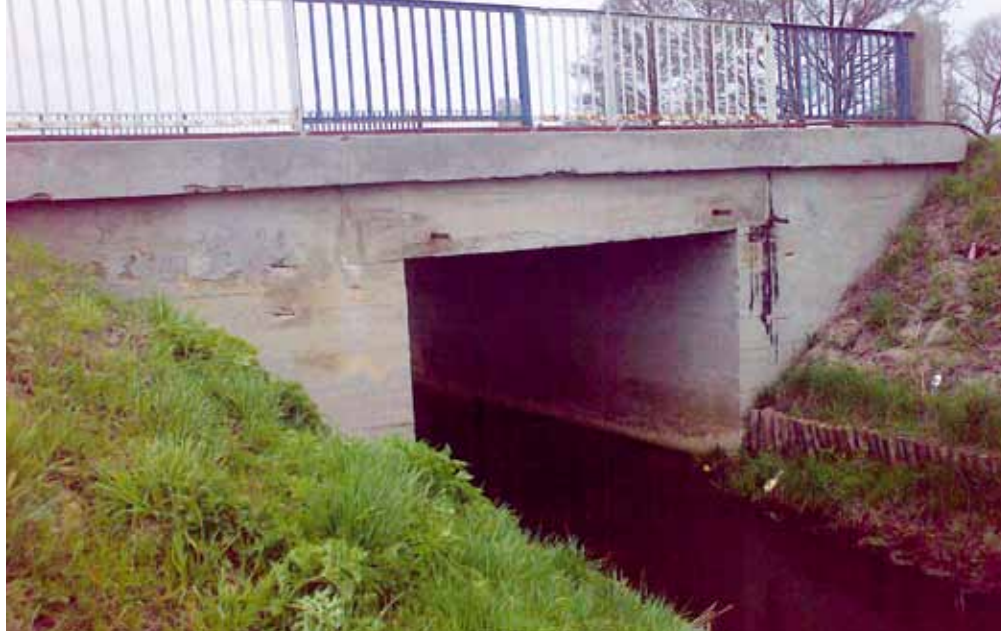
Stan obiektu nr 1, przed przebudową (2009), źródło J. Uczciwek
