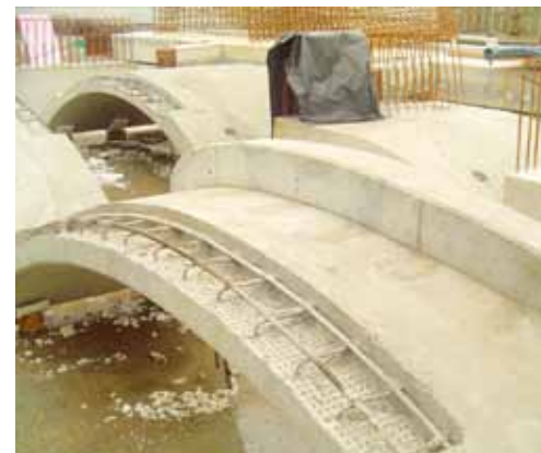
Gotowe elementy prefabrykowane, źródło Fabud WKB
