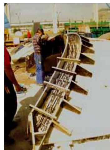
Dobetonowanie murku na elemencie skrajnym przepustu, źródło Fabud WKB
