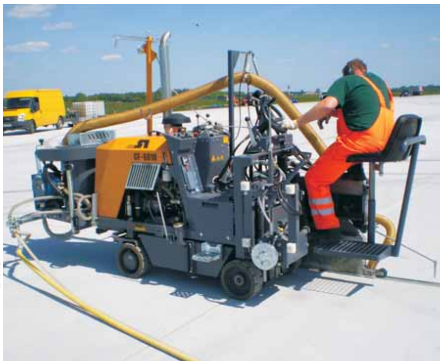
Rys. 1. Sposób wykonania szczeliny w betonie maszyną wieloczynnościową
