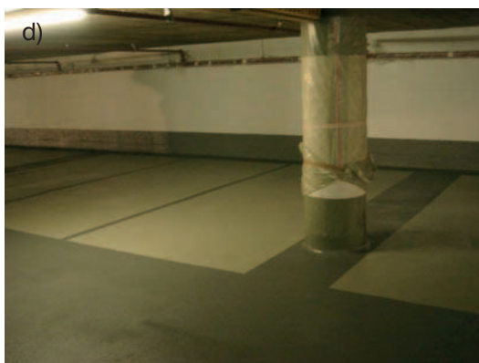
Rys. 1. a) Miejscowa korozja zbrojenia podłużnego, b) Dodatkowe podparcie modernizowanego stropu, c) Płyta stropowa z naniesioną nakładką systemową, d) Posadzka płyty parkingowej z pionowymi wywinięciami przygotowana do eksploatacji
