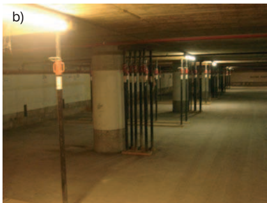
Rys. 1. a) Miejscowa korozja zbrojenia podłużnego, b) Dodatkowe podparcie modernizowanego stropu, c) Płyta stropowa z naniesioną nakładką systemową, d) Posadzka płyty parkingowej z pionowymi wywinięciami przygotowana do eksploatacji
