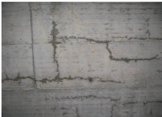
Rys. 3, 4. Przykładowe zarysowania powstałe na stropie I i II (widok od dołu)
