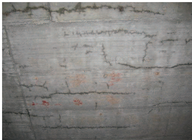
Rys. 1, 2. Przykładowe zarysowania powstałe na stropie I i II (widok od dołu)
