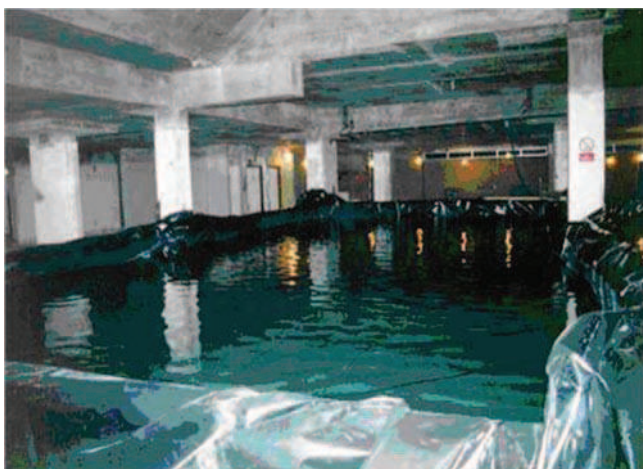
Rys. 1. Obciążenia próbne za pomocą wody w specjalnej wannie [8]
