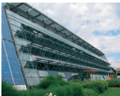
Rys. 1. Moduły fotowoltaiczne na elewacji Solar Fabrik i detal od frontu budynku (projekt: Rolf+Hotz Architektem, 1998)
