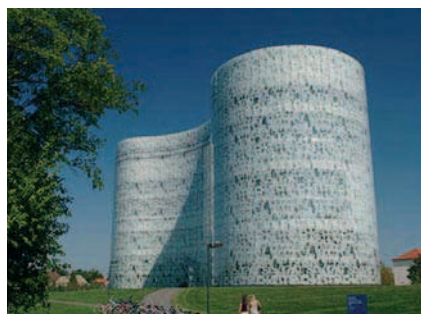
Rys. 3. Elewacja biblioteki w Cottbus z naniesionym wzorem w technice sitodruku (projekt: Herzog & de Meuron, 2005)
