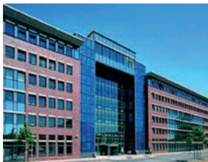
Rys. 2. Elewacja z polikrystalicznymi modułami PV obiektu Kalk Karrees w Köln – Kalk i detal, 2002
