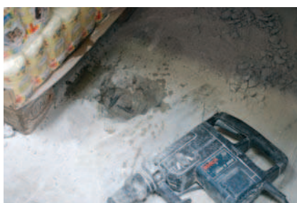
Rys. 4. Odkrywki zbrojenia płyty stropowej zbiornika w strefie pęknięcia
