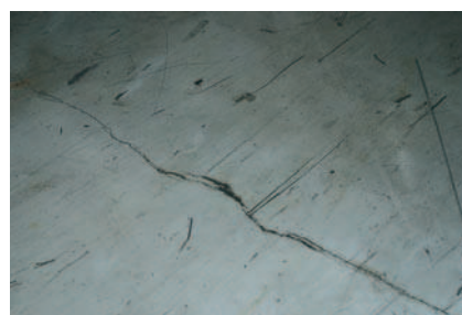
Rys. 3. Zarysowania posadzki zbiornika. Wnętrze komory zbiornika przeciwpożarowego
