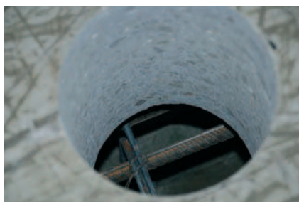
Rys. 6. Odwierty rdzeniowe płyty zbiornika. Próbki przygotowane do badań w maszynie wytrzymałościowej [9]
