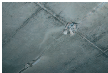
Rys. 4. Odkrywki zbrojenia płyty stropowej zbiornika w strefie pęknięcia
