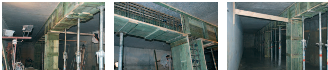
Rys. 8. Realizacja wewnętrznej konstrukcji wzmacniającej płytę zbiornika
