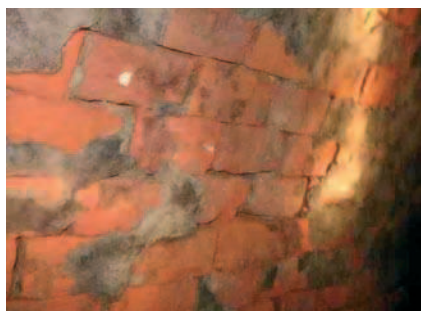
Rys. 17. Uzupełnienie większych ubytków zaprawą mineralną [3]
