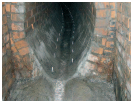
Rys. 16. Uszczelnianie dolnej części konstrukcji kolektora za pomocą iniekcji żywicami syntetycznymi [2]
