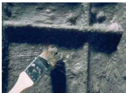
Rys. 18. Zabezpieczenie odkrytego zbrojenia konstrukcji [3]
