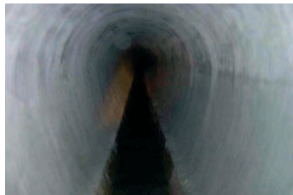
Rys. 19. Kolektor kanalizacyjny po renowacji zaprawami mineralnymi [4]
