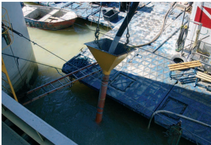
Rys. 4. Reprofilacja górnych fragmentów przelewów powierzchniowych zapory
