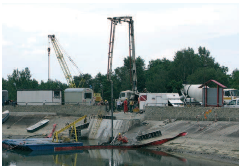
Rys. 1. Betonowanie przegrody między komorami ujęcia. Po prawej schemat wzmacnianej konstrukcji
