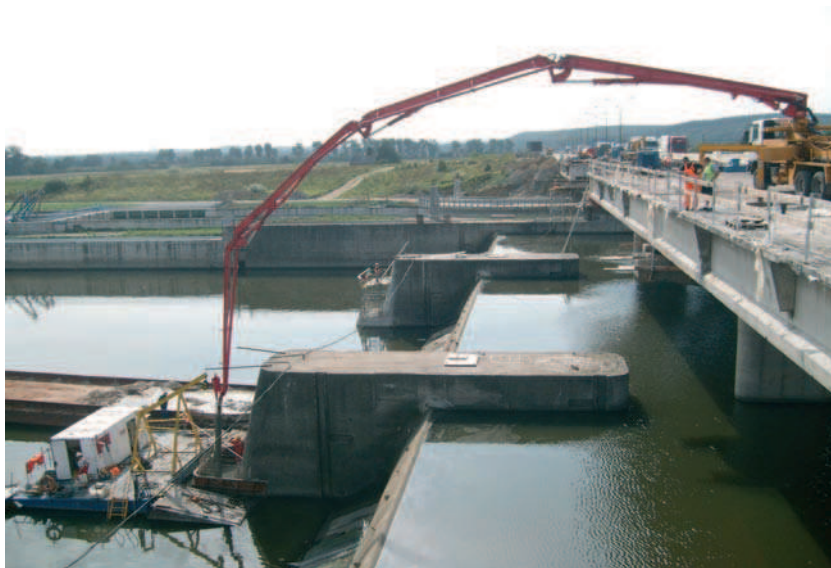
Rys. 2. Betonowanie podwodnej części nurtowej podpory kładki. Po prawej schemat wydłużenia filara
