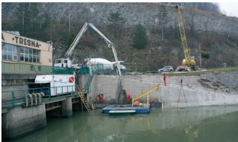
Rys. 3. Mur oporowy niecki wypadowej w trakcie remontu oraz schemat jego wzmocnienia
