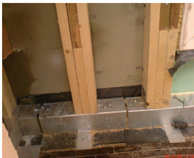
Rys. 8. Widok konstrukcji ścian po naprawie
