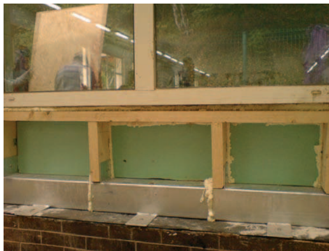
Rys. 7. Widok wymienionej konstrukcji ścian pod parapetem okna
