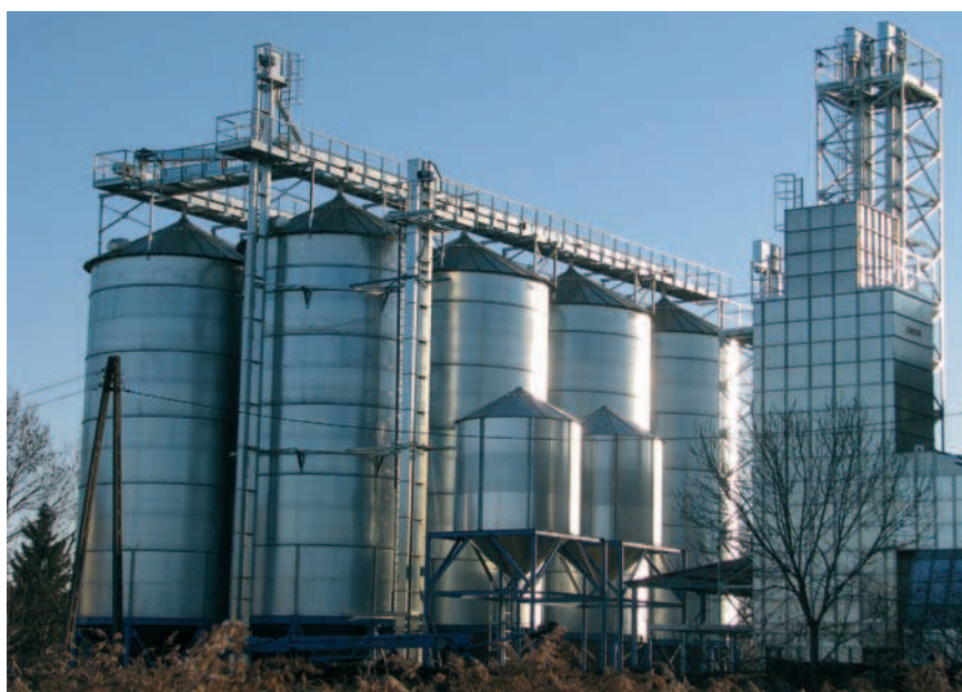
Rys. 1. Bateria silosów z cienkich blach (zdjęcie opublikowane dzięki uprzejmości firmy AGREMO [10])
