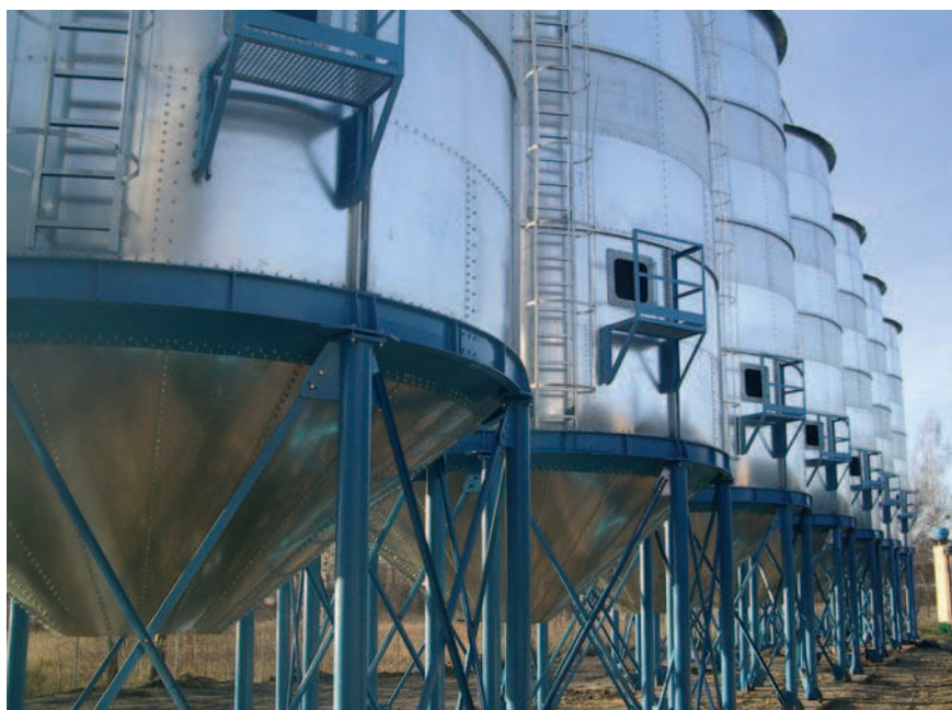
Rys. 2. Silosy lejowe – widoczne pierścienie podporowe wsparte na słupkach z rur (zdjęcie opublikowane dzięki uprzejmości firmy AGREMO, [10])
