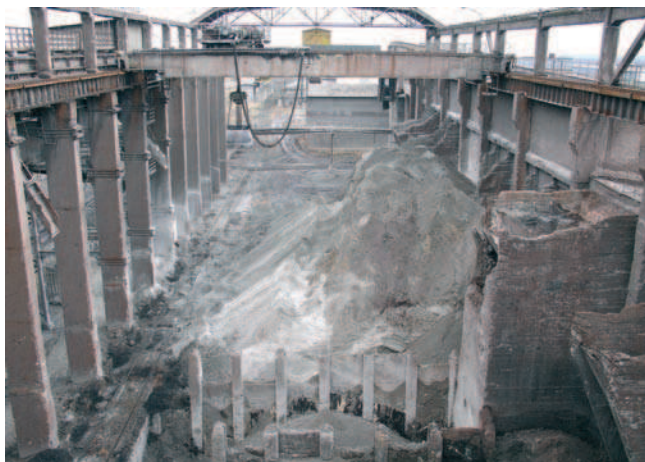
Rys. 2. Wnętrze niezadaszonej części hali od strony wschodniej – skład gipsu
