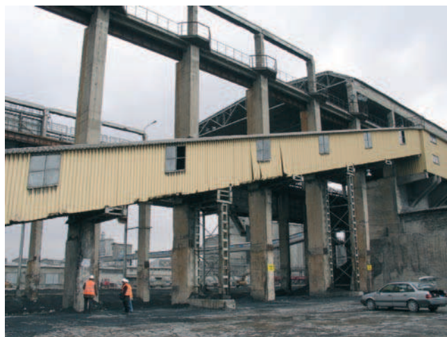
Rys. 1. Skład węgla w zachodniej części hali – widoczny obudowany taśmociąg zamocowany do słupów
