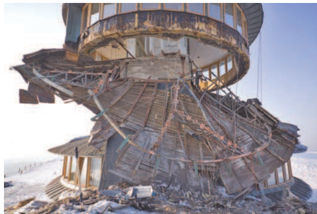
Rys. 3. Konstrukcja wraz z obudową przed usunięciem zniszczonych elementów
