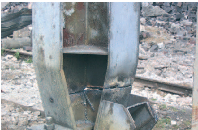
Fot. 1. Przykład podcięcia słupa stalowego przed wyburzeniem fundamentu
