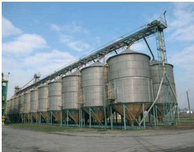
Fot. 1. Bateria silosów z blachy falistej z 1978 roku do przechowywania zbóż i pasz rolniczych
