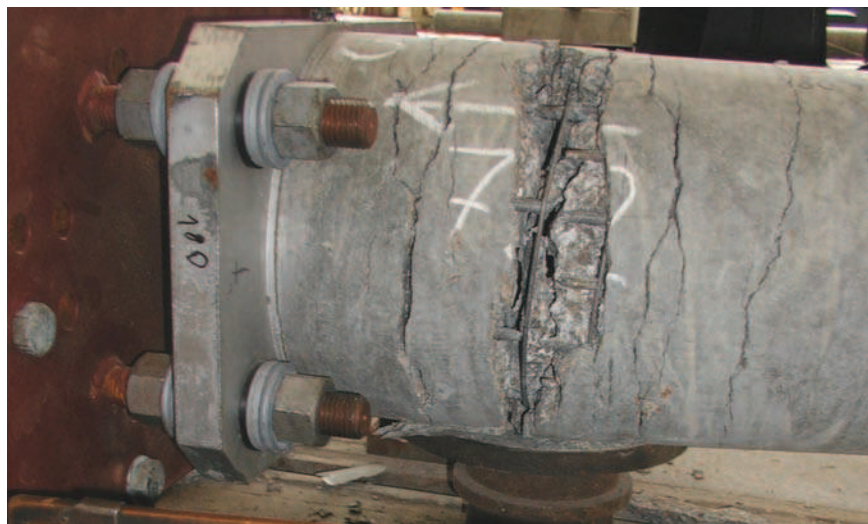
Rys. 11. Widok na zniszczony po badaniu na zginanie słup ETG-1c
