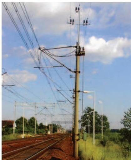
Rys. 3. Słup krzyżowy ET-2 z betonu wirowanego na linii E 59 w rejonie stacji Wrocław – Osobowice (montaż: lipiec 1995 r.)
