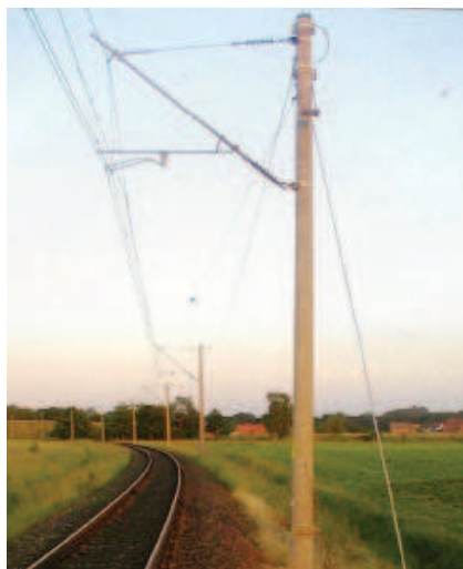
Rys. 4. Sekcja naciągowa na torze doświadczalnym w Węglewie k. Żmigrodu zmontowana na słupach wirowanych typu ET-1 i ET-2 (montaż: sierpień 1996 r.)
