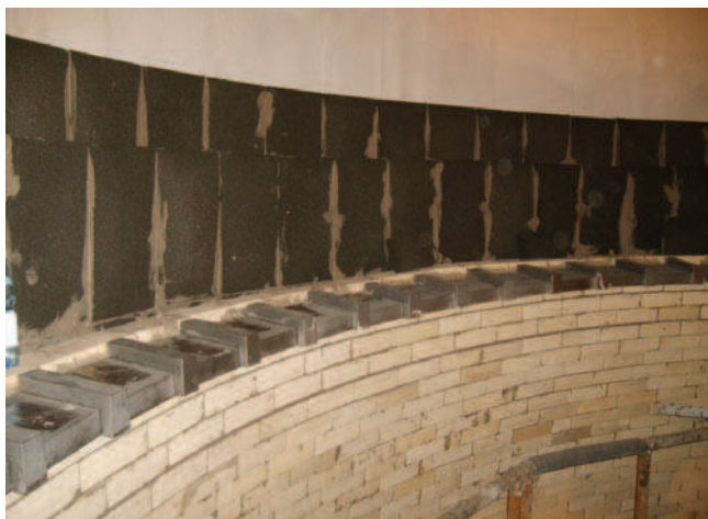
Rys. 3. Żeliwne kształtki zamykające dylatację poziomą wymurówki
