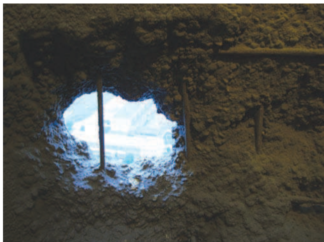
Rys. 1. Perforacja trzonu żelbetowego
