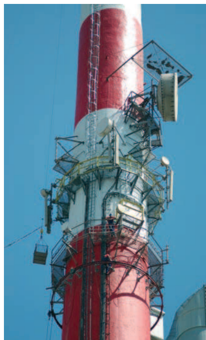
Rys. 4. Duża ilość anten nadawczych na trzonie komina
