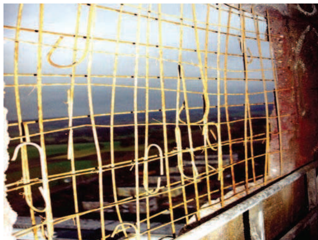
Rys. 4. Przykład otworu wykutego na całą grubość powłoki z powodu niskiej wytrzymałości betonu
