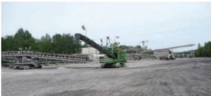
Rys. 3. Otwarte składowisko tymczasowe popiołów z elektrowni
