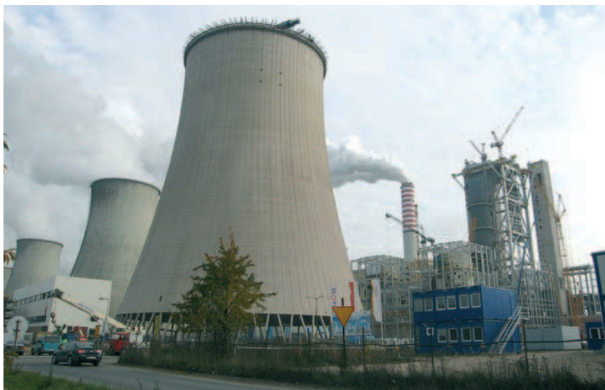
Rys. 2. Budowa nowego bloku energetycznego nr 13 w PGE Elektrowni Bełchatów S.A.
