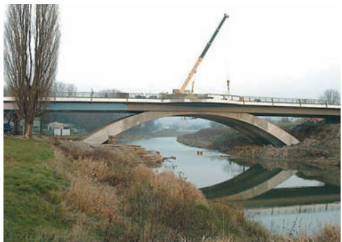
Most Zamkowy w Rzeszowie z łukami rozpiętości 50 m, wykonane z betonu samozagęszczonego
