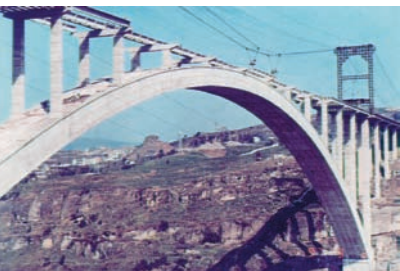
Betonowy most łukowy Wanxian o rekordowej rozpiętości 420 m w trakcie budowy
