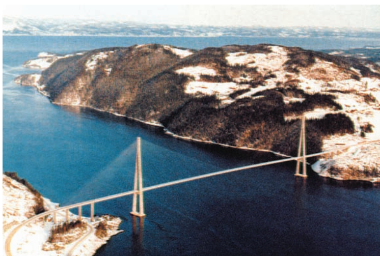
Betonowy most podwieszony Skarnsundet o rekordowym przęsle rozpiętości 530 m
