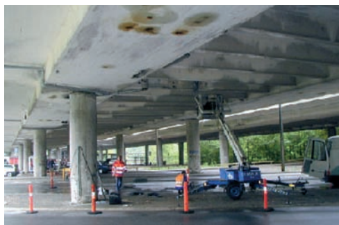
Fot. 3 Widok wiaduktu autostradowego, na którym wykonano prototypową instalację systemu monitorowania zagrożenia korozyjnego
