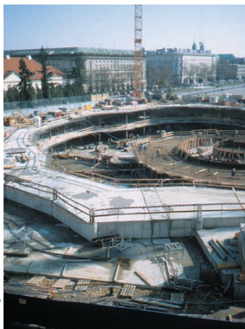
Widok pierścieni w trakcie budowy
