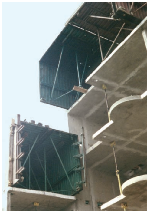
Fot. 1. Kolizyjne ustawienie urządzeń formujących
