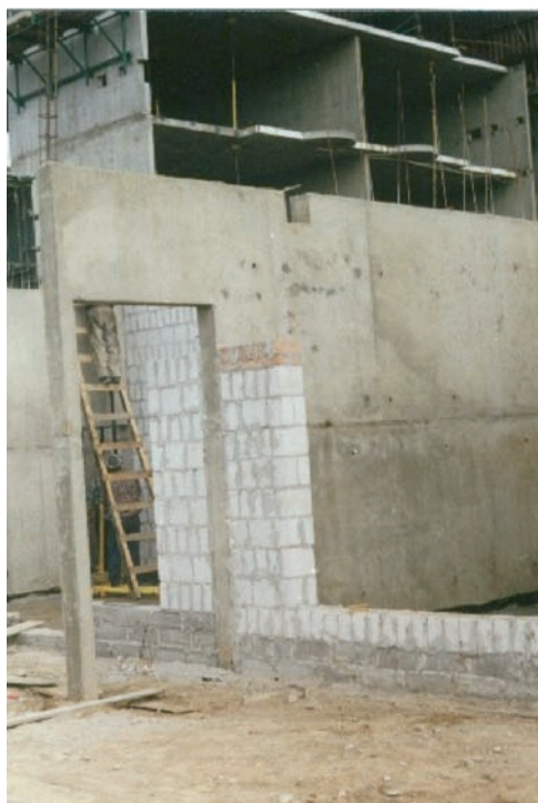
Fot. 3. Rozdzielcze wykonanie ścian i stropów w segmencie C
