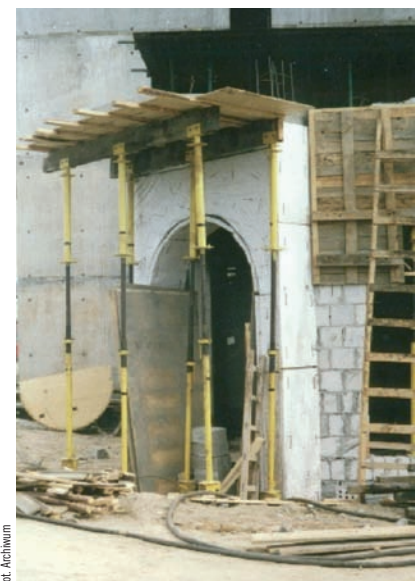
Fot. 2. Realizacja półkolistego balkonu w odrębnym cyklu technologicznym
