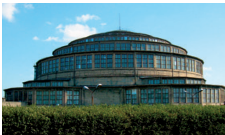
Fot. 2. Elewacja przed remontem, październik 2007
