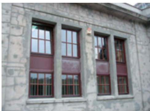
Fot. 5. Powierzchnia betonu po wykonaniu napraw
