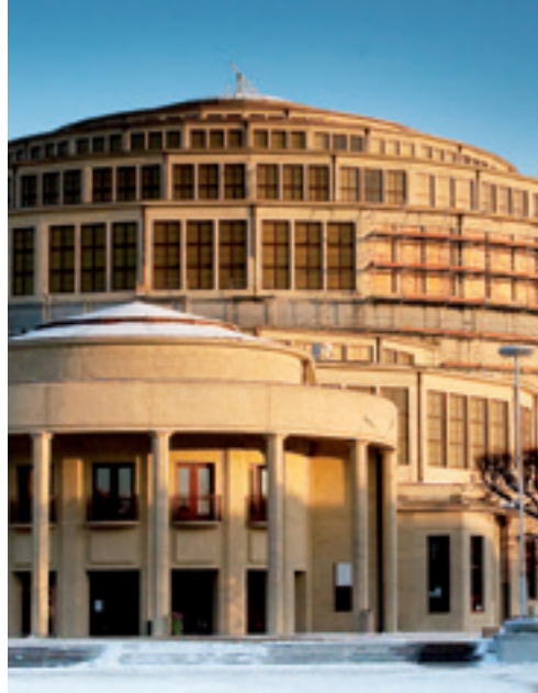
Fot. 8a. Elewacja w końcowej fazie remontu, grudzień 2009
