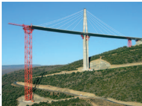
Fot. 7. „Parkowanie” na podporach stałych i montażowych
