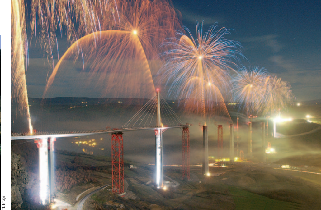
Fot. 4. Świątowanie zakończenia betonowania filarów (grudzień 2003)
