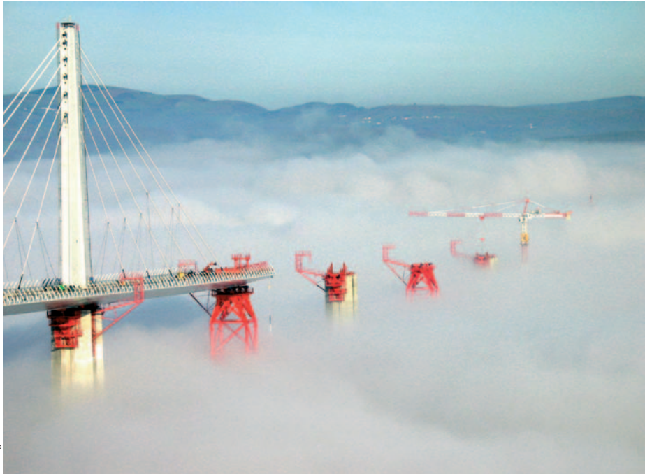
Fot. 8. Nasuwanie pomostu ponad chmurami
