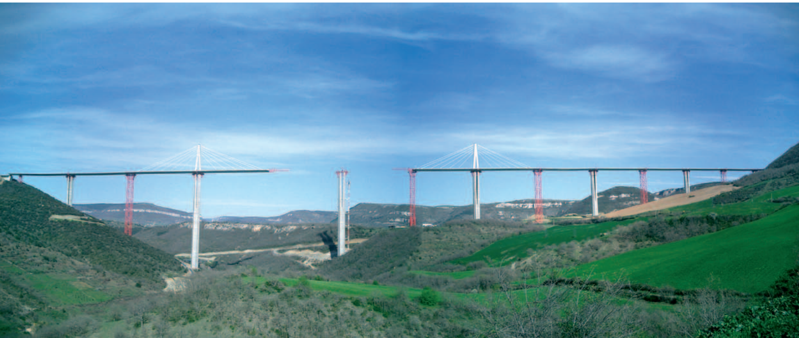
Fot. 9. Zakończenie nasuwania odcinka północnego (z lewej)
