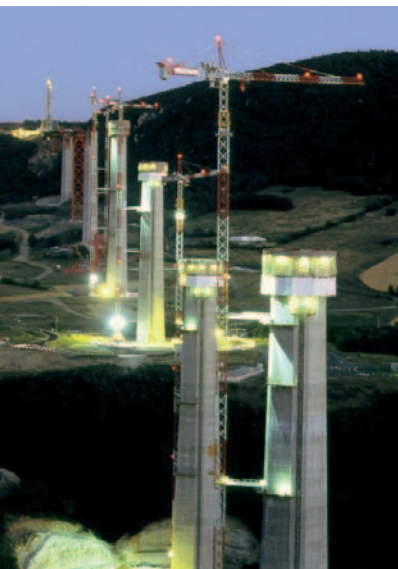
Fot. 3. Betonowanie na drugiej zmianie
