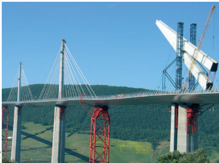
Fot. 12. Montaż stalowych pylonów – faza (7)
