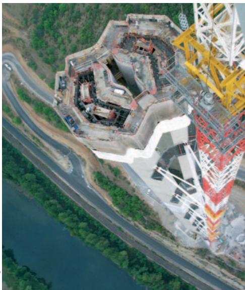
Fot. 1. Przekrój filara wiaduktu w czasie betonowania – widok z wysięgnika żurawia
