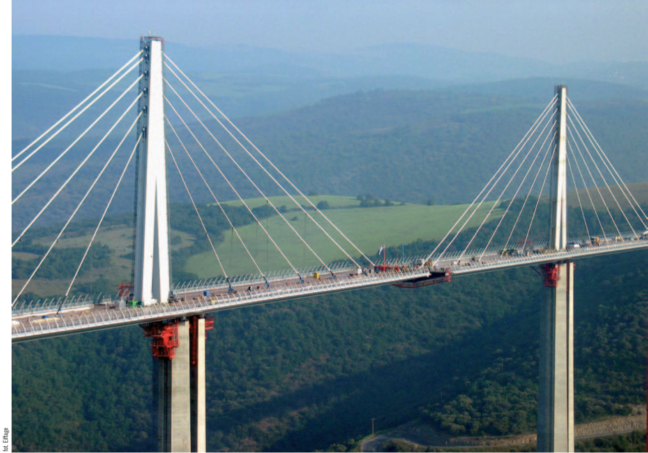
Fot. 10. Parę metrów przed połączeniem pomostu (czerwiec 2004)
