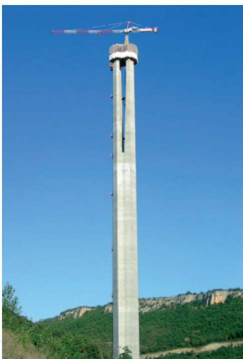
Fot. 2. Najwyższy filar (245 m) w końcowej fazie betonowania
