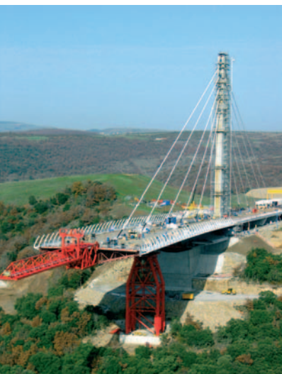
Fot. 5. Początek nasuwania południowego odcinka (wrzesień 2003)
