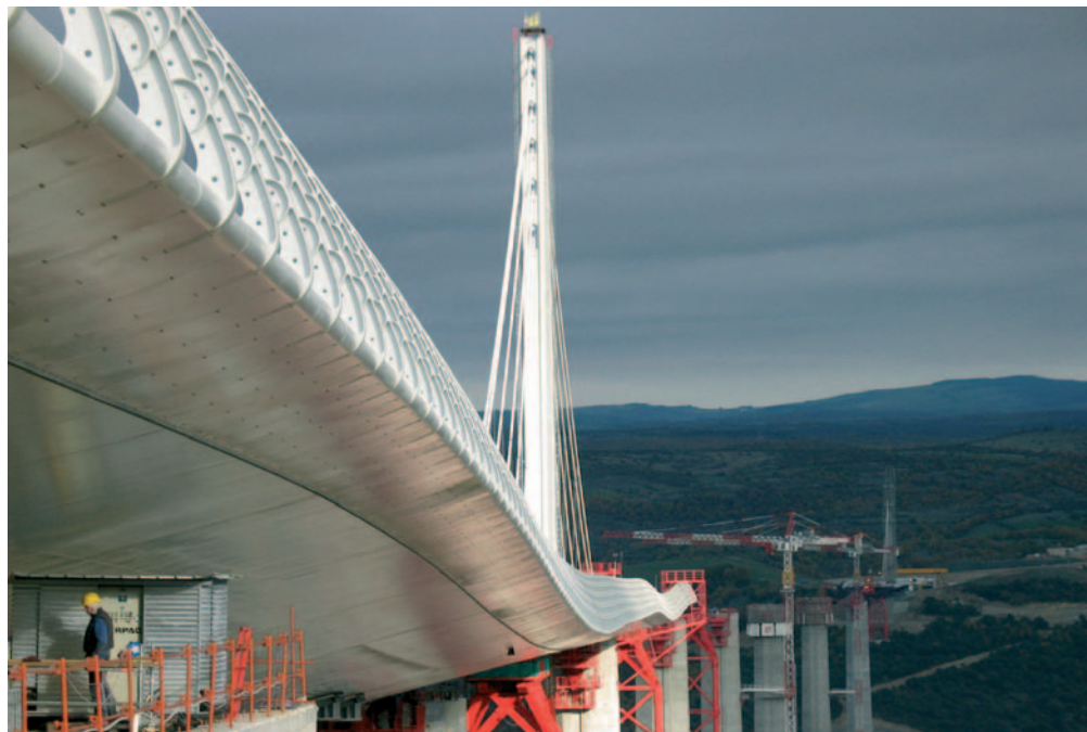
Fot. 6. Nasuwanie podatnego pomostu
