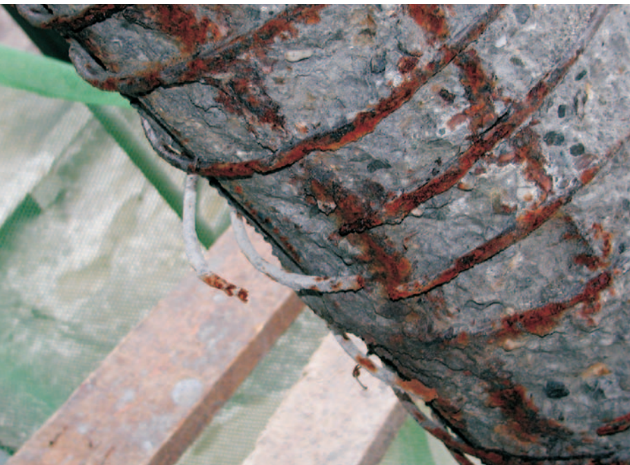
Fot. 3. Słupy uzwojone konstrukcji wsporczej chłodni kominowej – czy nie należało uwzględnić problemu trwałości?
