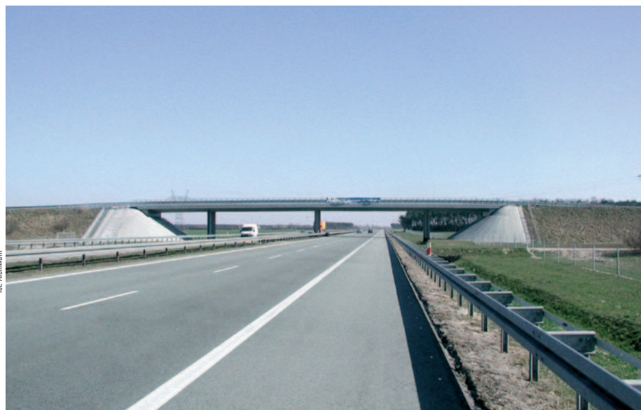
Fot. 1. Zmodernizowany wiadukt drogowy WD-53 w ciągu autostrady A2
