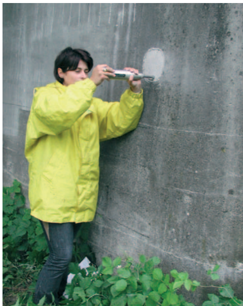
Fot. 2. Sklerometr Schmidta typu „N” w czasie badania masywnej podpory mostowej
