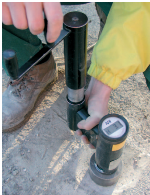
Fot. 4. Pomiar „pull-off” – widok siłownika hydraulicznego w czasie pomiaru
