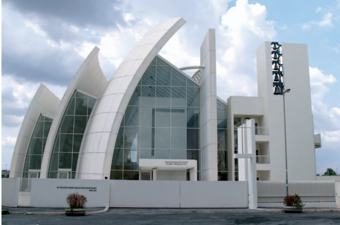
Fot 1. Kościół Dives in Misericordia – przykład zastosowania betonu samooczyszczającego się
