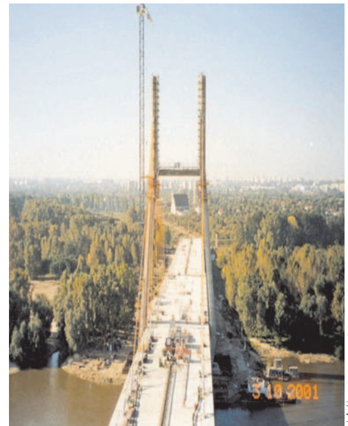
Fot. 3. Budowa pylonu mostu Siekierkowskiego (2003)
