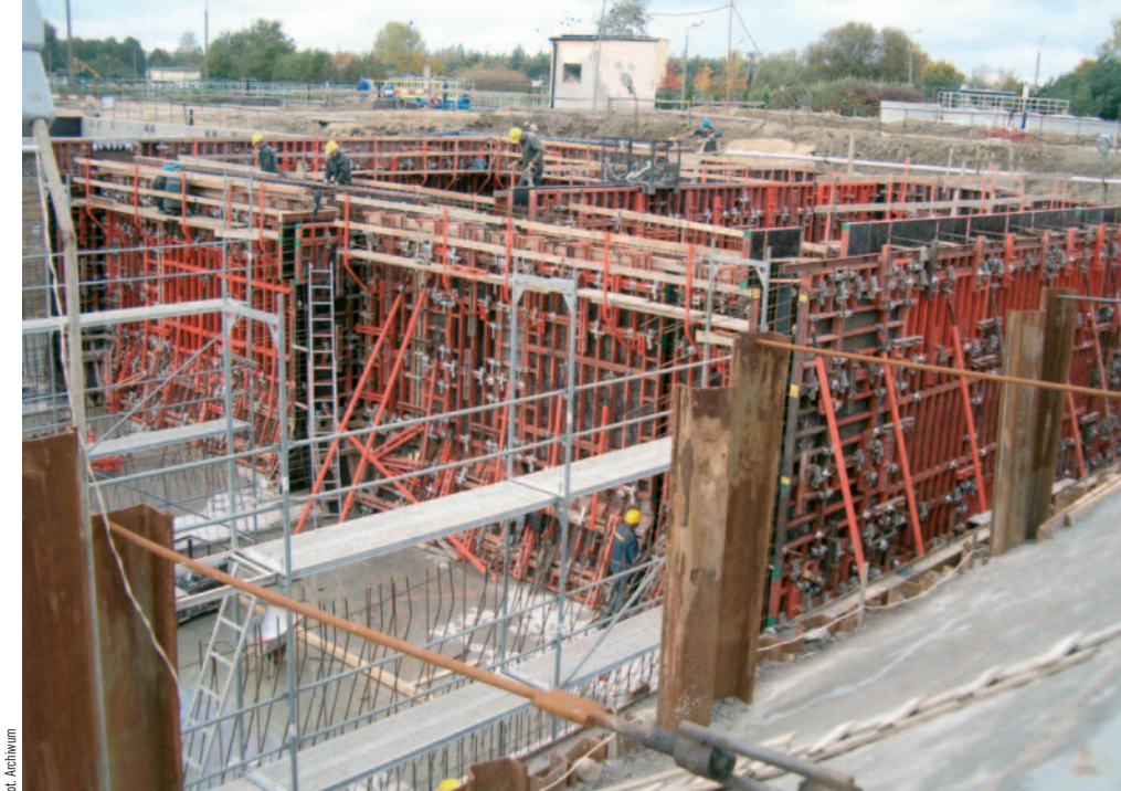
Fot. 2. Ogólny wygląd betonowanego zbiornika
