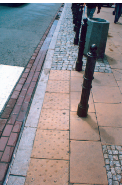
Fot. 2. Przykłady rozwiązań z zastosowaniem dużych płyt betonowych (Warszawa)
