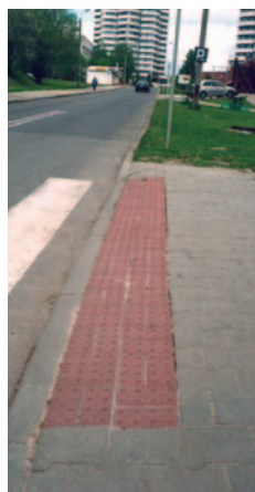
Fot. 1. Przykłady rozwiązań z zastosowaniem małych płytek betonowych – Katowice
