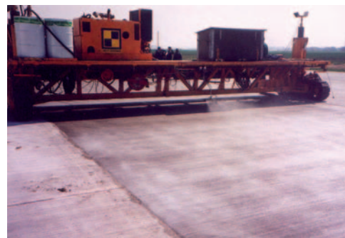
Fot. 10. Zabezpieczenie płyty lotniskowej preparatem powłokowym
