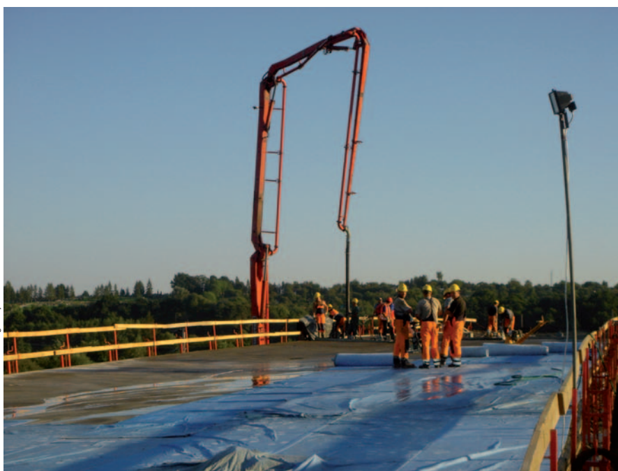
Fot. 8. Zabezpieczenie betonu włókniną polewaną wodą
