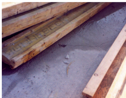
Fot. 3. Pęknięcie płyty stropowej wskutek skurczu twardnienia
