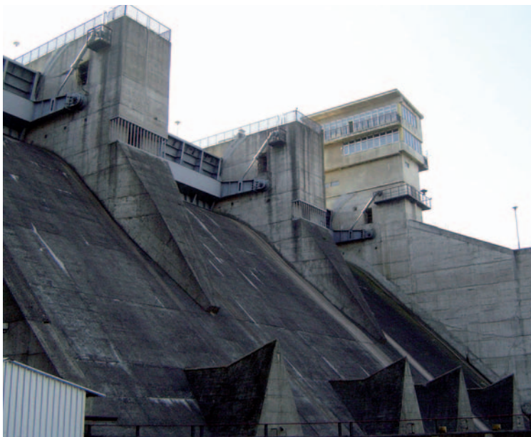
Blok przelewowo-spustowy zapory w Dobczycach na Rabie
