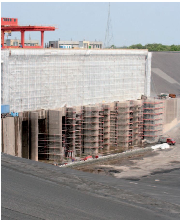
Budowla wlotowa EW Żarnowiec, w remoncie
