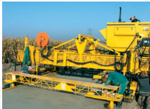
Fot. 2. Układarka mieszanki betonowej „Gomaco”
