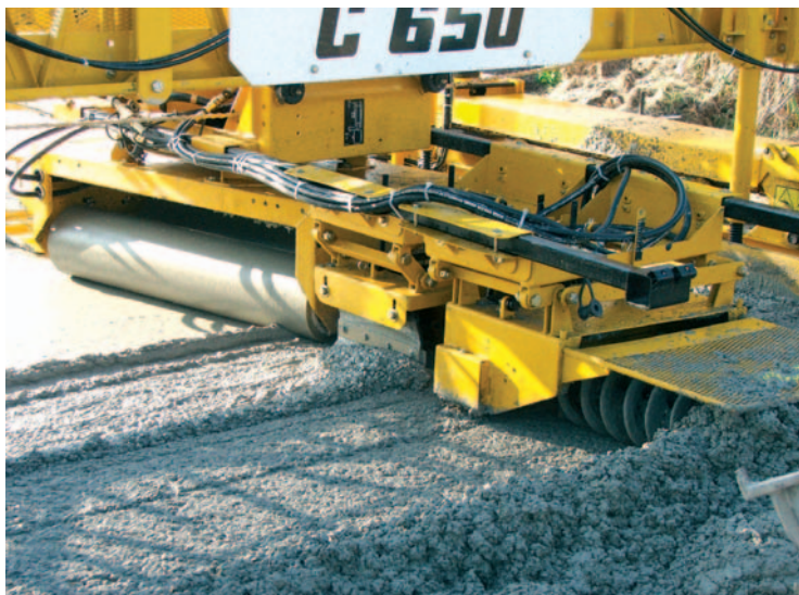
Fot. 3. Układanie i zagęszczanie mieszanki betonowej
