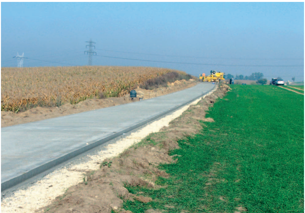
Fot. 5. Betonowa droga Ujazd – Zimna Wódka
