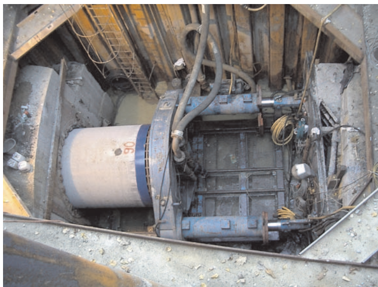
Fot. 2. Widok montażu rury żelbetowej technologią mikrotunelowania
