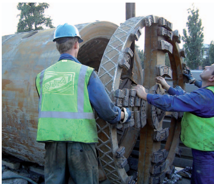
Fot. 3. Montaż głowicy do mikrotunelowania
