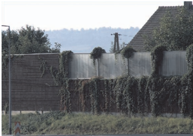
Ekran akustyczny wykonany ze żrękbetonu, porośnięty roślinnością
