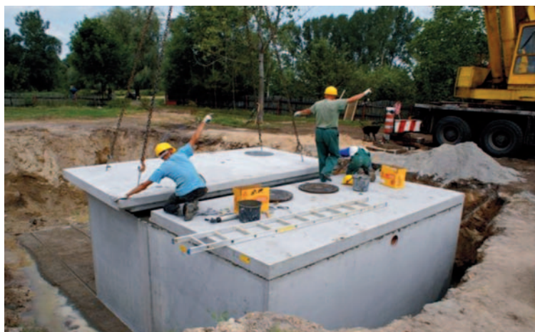
Montaż płyt stropowych
