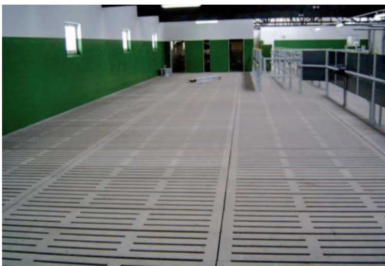
Prefabrykowane ruszty w oborze
