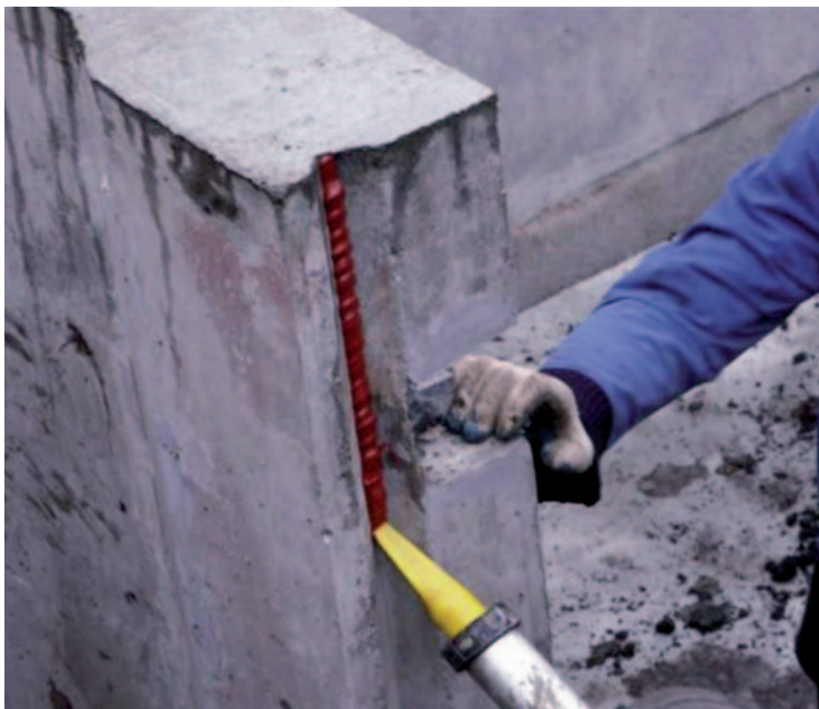
Układanie poliuretanowej masy pęczniejącej
