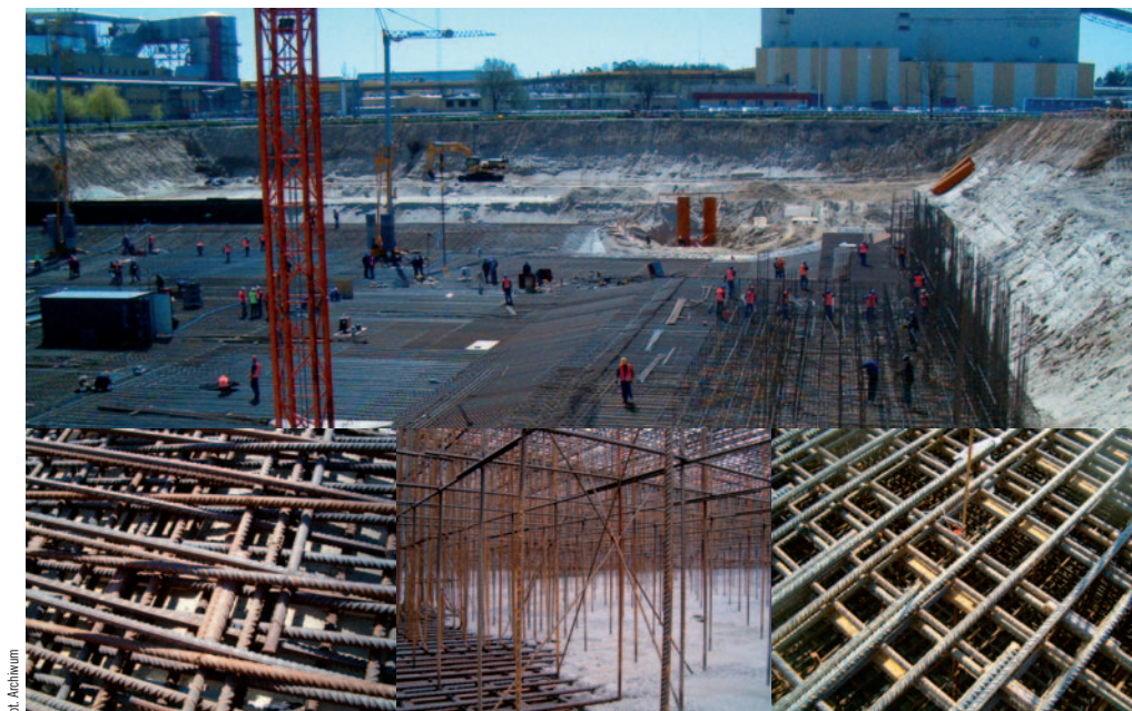
Rys. 2. Obraz sposobu zbrojenia elementu płyty fundamentowej
