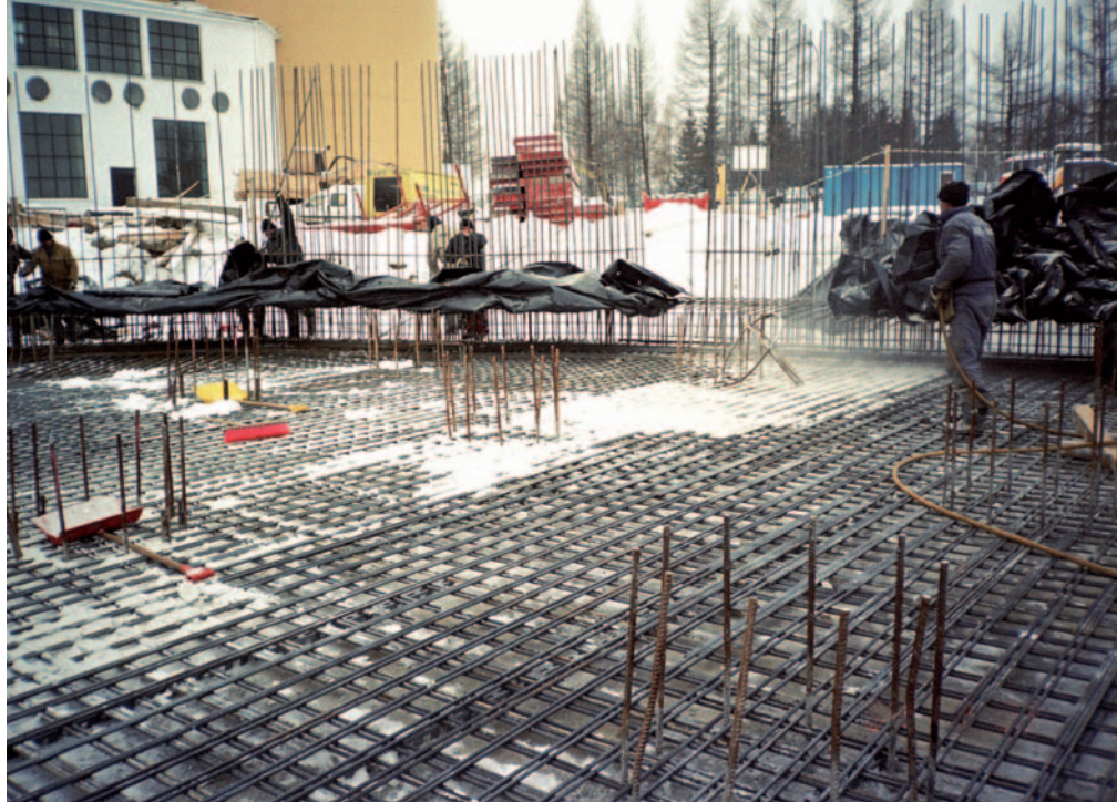
Usuwanie śniegu i lodu przed betonowaniem
