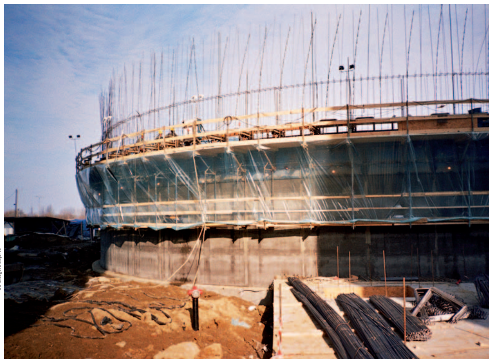
Betonowanie ślizgowe – osłona i nagrzewanie strefy betonowania
