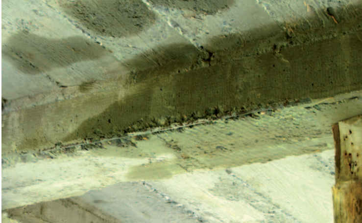
Przemrożona płyta stropowa
