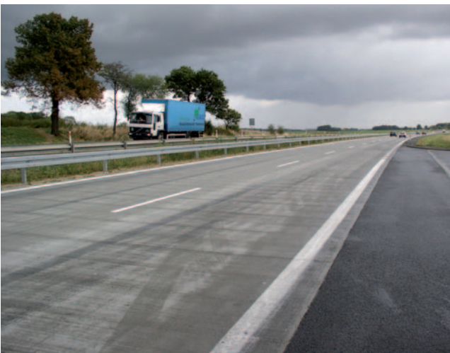
Fot. 5. Budowa nawierzchni o ciągłym zbrojeniu – wykonana nawierzchnia
