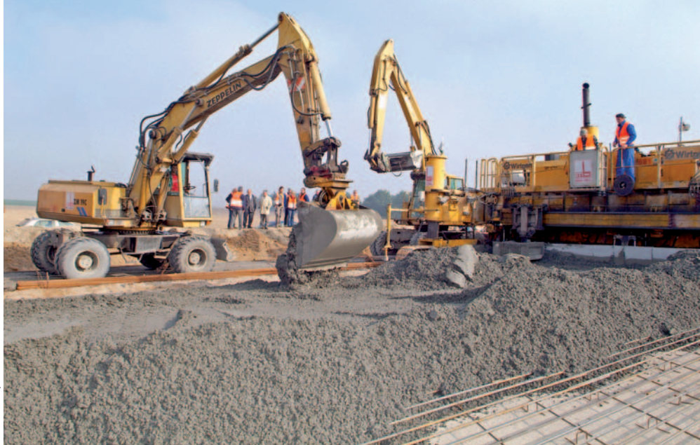
Fot. 2. Budowa nawierzchni o ciągłym zbrojeniu – układanie betonu
