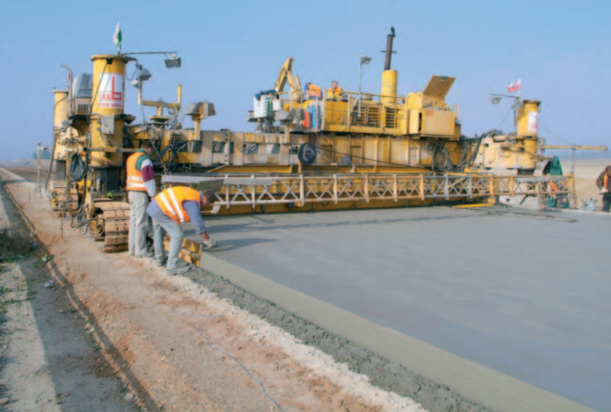
Fot. 4. Budowa nawierzchni o ciągłym zbrojeniu – beton po ułożeniu
